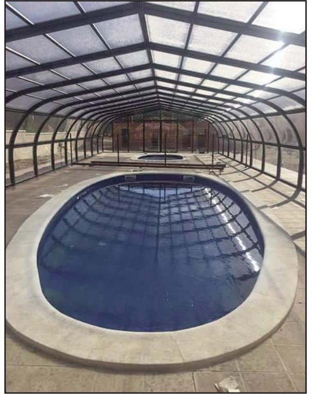
grados. La cápsula que se ha colocado hace efecto invernadero, entra el calor pero no sale. En verano la cápsula se puede levantar y quedar las piscinas al descubierto”.
